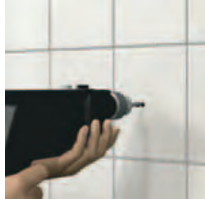
Просверлите отверстия в плитке для установки соответствующих дюбелей.
