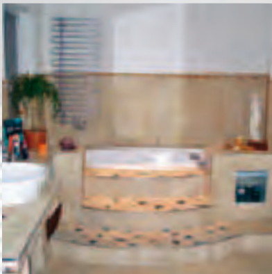
Декорирование ванны со ступенями и бордюром, облицовка плиткой.
