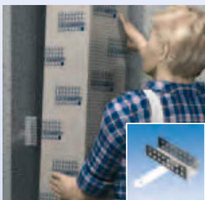
LUX ELEMENTS®-MONT U – к примеру, обшивка труб для настенного монтажа
