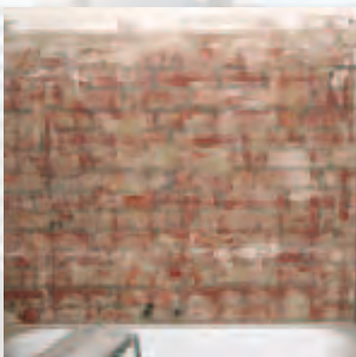
«Отчищенная» стена ванной комнаты перед облицовкой строительными панелями ELEMENT ...
