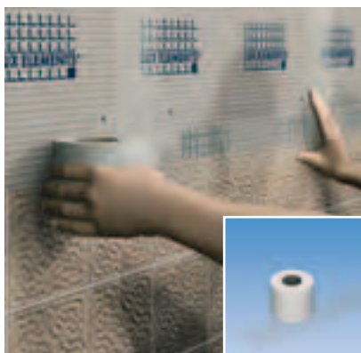
к примеру, LUX ELEMENTS®-ARM-100 SK – самоклеющаяся для переходов и плоских стыков.
