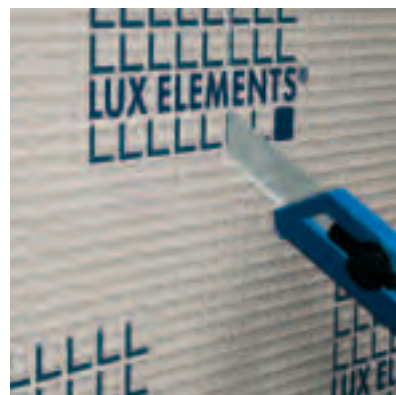
Несущий материал из жестковспененного полистирола прорезается параллельно резаком, жестковспененный полистирол удаляется соответствующим инструментом (например, отверткой) настолько глубоко, сколько необходимо, устанавливаем и выравниваем с COL-PU или COL-AK.
