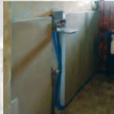
Подготовка стены под установку санитарно-технического оборудования.
