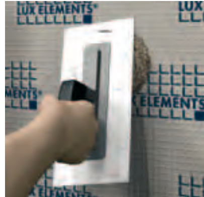
Несущий материал из жестковспененного полистирола вырезается резак, жестковспененный полистирол выскабливается наружу, заполняется COL-AK в котором укрепляются крепежные элементы.
