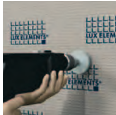
Отверстие в ELEMENT просверливается кольцевым сверлом.
