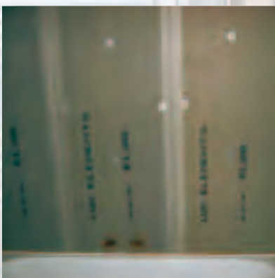
... после облицовки ELEMENT, готовая к приклеиванию плитки ...
